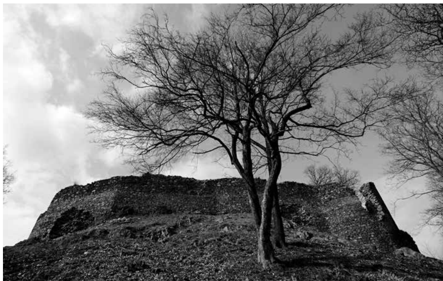
Zřícenina hradu Blansko před opravami obvodových zdí (foto J. Preclík)
